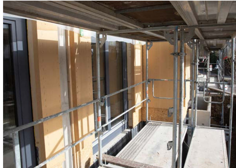
Gebäudefassade mit Holzfaserdämmstoff
